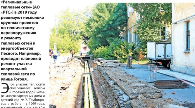
На отрезке между домами №№ 5 и 7 по улице Гоголя выполнены земляные работы, демонтирован прямой и обратный трубопровод, выполнен монтаж обратного трубопровода.
