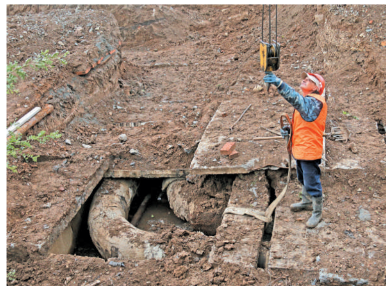
Ремонт участка тепловой сети, который обеспечивает тепло и горячей водой район от улицы Кирова до улицы Мира и старую часть города, идёт полным ходом.
