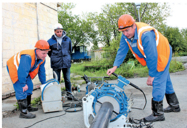
Слесари А.Дудников и В.Жиделёв под руководством начальника участка А.Савостина производят сварку полиэтиленовой трубы.
