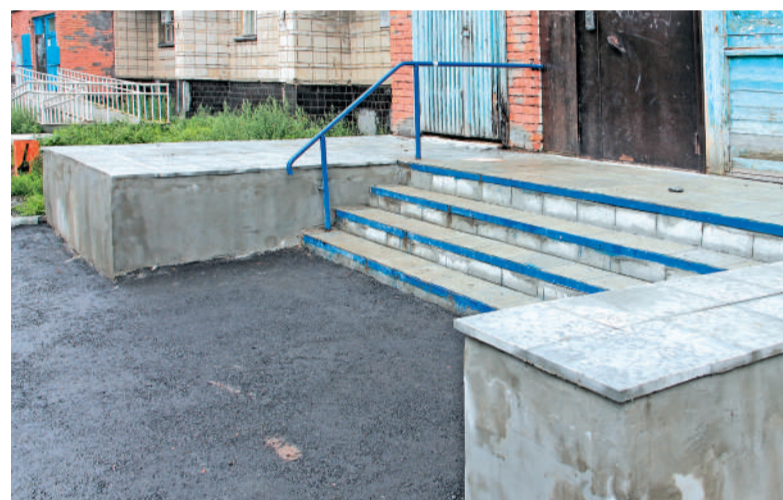
Так выглядят отремонтированные крыльца дома № 88 по улице Ленина, такими же будут и крыльца дома № 92.
