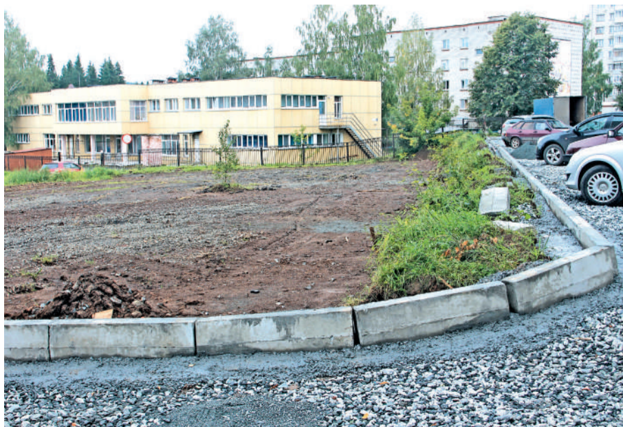
Во дворе домов № 14 и № 20 по улице Строителей установлены бордюры по границам планируемых автостоянок и проезжей части.
