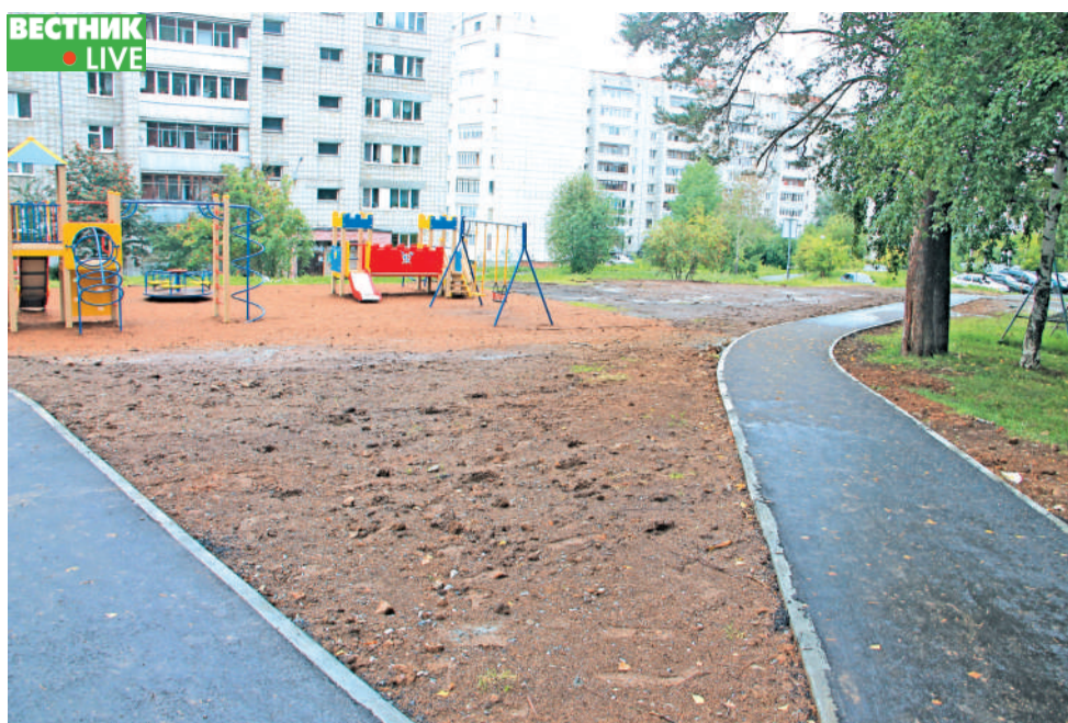
Во дворе домов №№ 88 и 92 по улице Ленина уложено асфальтовое покрытие тротуаров и проезжих частей, установлено детское и спортивное оборудование.
