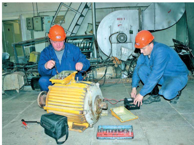
Электромонтёры С.Мальшев и А.Горбунов осуществляют осмотр и планово-предупредительный ремонт электродвигателя к насосу.
