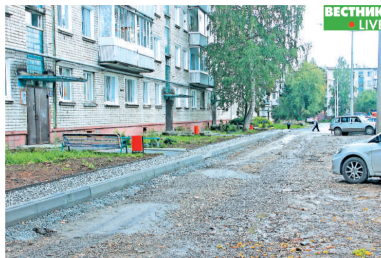
На внутриквартальной территории общего двора домов № 36, 38, 40, 46 по улице Победы и дома № 62 по улице Кирова идёт отсыпка щебнем и подготовка к укладке асфальта на проезжей части и тротуарах.
