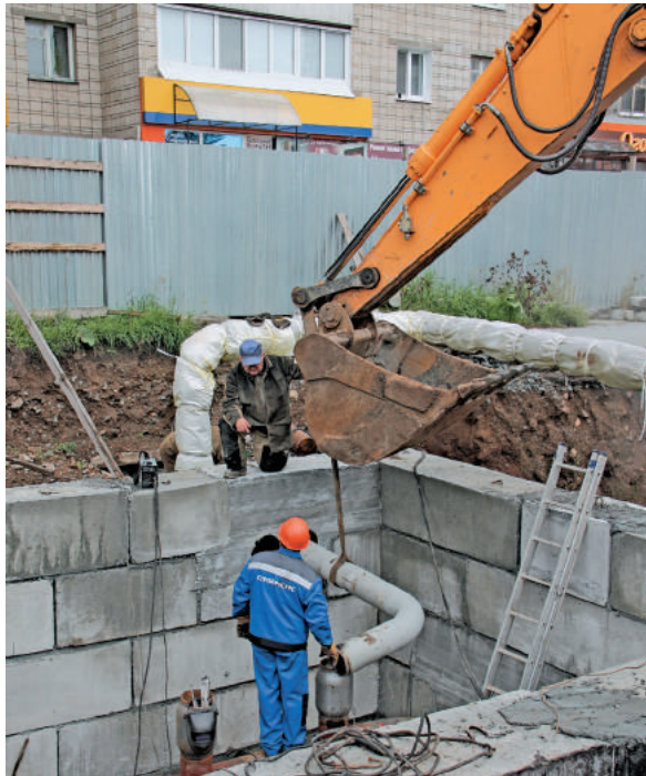
Работы по переключению домов от временного трубопровода к постоянному.
