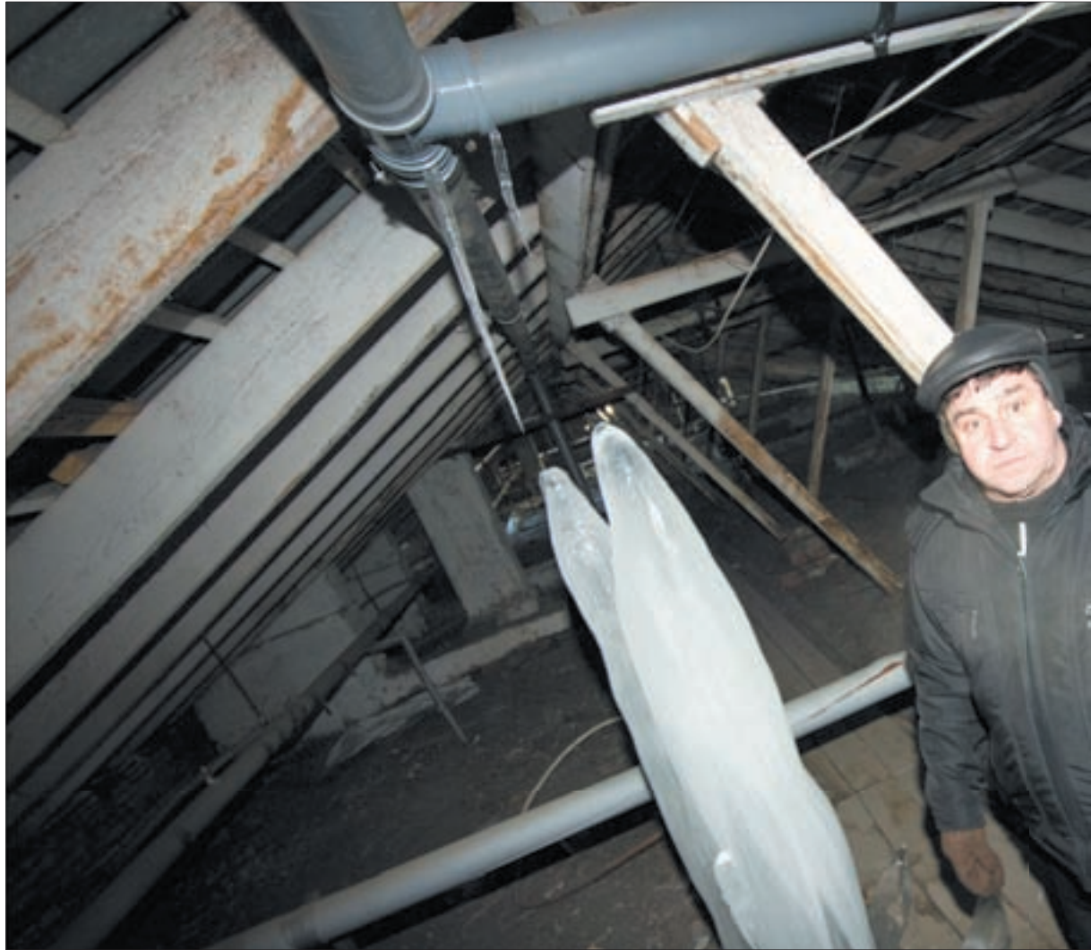
Трубы, проложенные на чердаке, протекают, порождая вот такие сталактиты и сталагмиты. «Это надо Селедкову спрашивать, какие они нам клапана поставили, что все бежит», — ругается житель дома Владимир Сарапулов.
