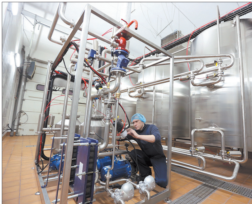
Участь централизованной мойки, наладчик Сергей Тетерин настраивает работу клапанов.
