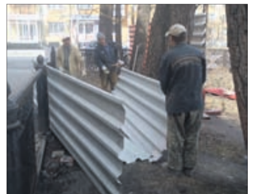
Конец апреля — начало мая 2011 года. Рабочие оградили строительную площадку.
