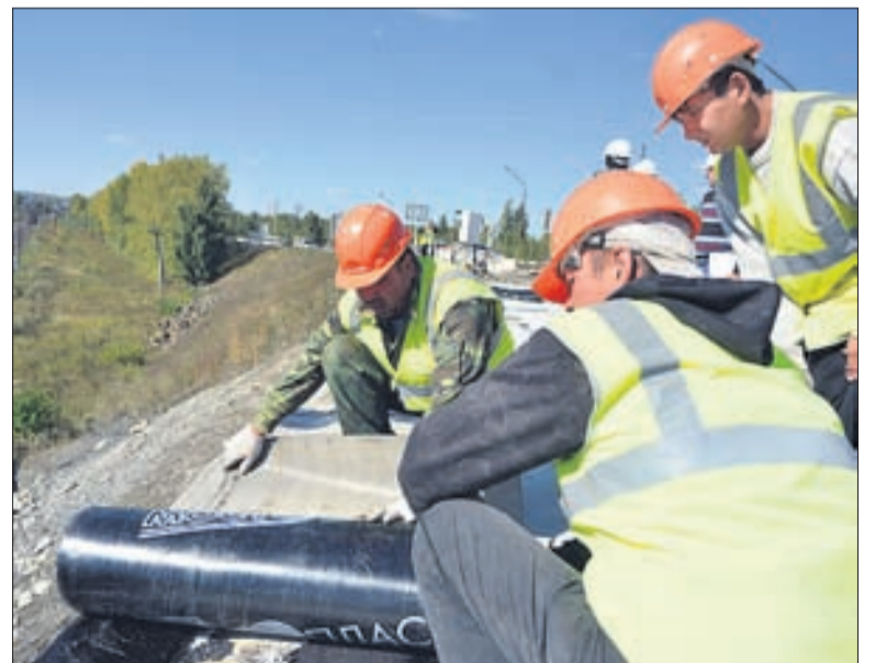
МОСТОУПЛАСТ — наплавляемый рулонный гидроизоляционный материал на основе битумно-полимерного вяжущего слоя, армированного полиэфирным нетканым волокном. В качестве защитного покрытия используется мелкозернистая посыпка с лицевой стороны и полиэтиленовая пленка — с другой стороны. Срок службы — не менее 30 лет.
