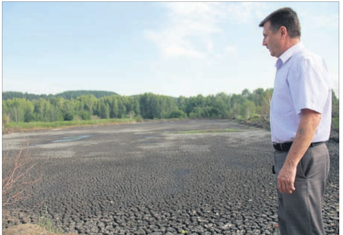
Иловая площадка — это те отходы, что остаются от очистки канализационных стоков.
