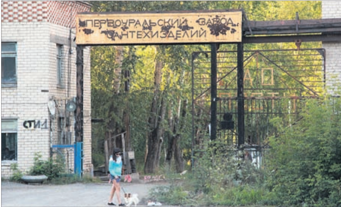
В Советском Союзе завод СанТехИзделий был одним из двух подобных заводов в стране. Разорился. Сейчас это пустующие здания.
