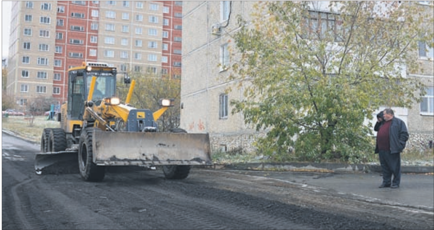
Фото Анастасии Пономаревой На Емлина техника появилась в пятницу, 4 октября. Здесь — укладка асфальта, без бордюра. Рабочие справились за день. Сколько прослужит покрытие — покажет время.
