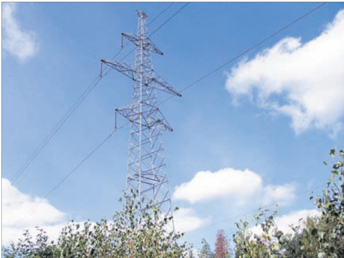
Это не первый случай повреждений ЛЭП ОАО «МРСК Урала» сторонними лицами. Так, в начале августа из-за действий «черных лесорубов» около 15 тысяч человек остались без света в поселке Карабаш Челябинской области. Падение дерева на провода вызвало отключение двух линий электропередачи классом напряжения 110 кВ: «Карабаш — Кыштым» и «Тайгинка — Пирит». Обесточенными оказались не только население, но и мощности градообразующего предприятия «Карабашмедь», сообщили www.pervo.ru в пресс-службе «МРСК Урала».
