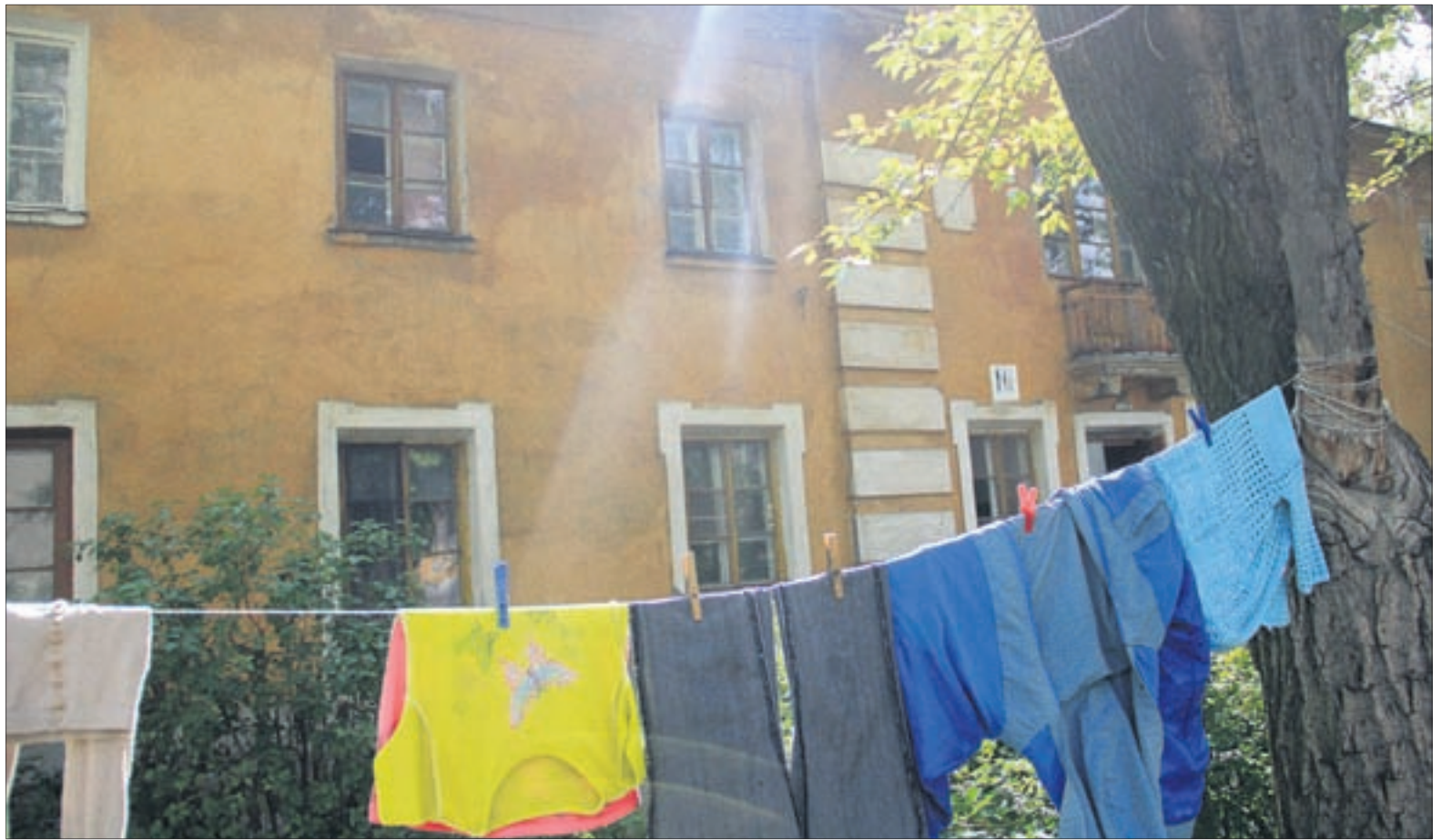
Дома поствоенной постройки еще крепкие, но очень запущенные — капитальный ремонт необходим.
