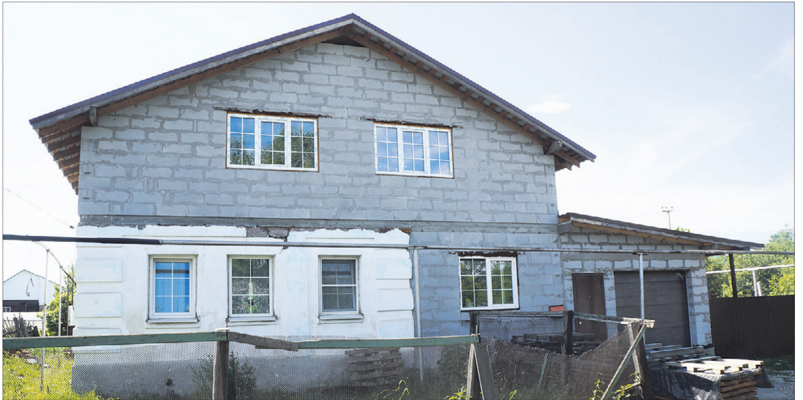
На фото — дом, подвергшийся реконструкции. Обновление — более простая процедура, не требующая согласования.
