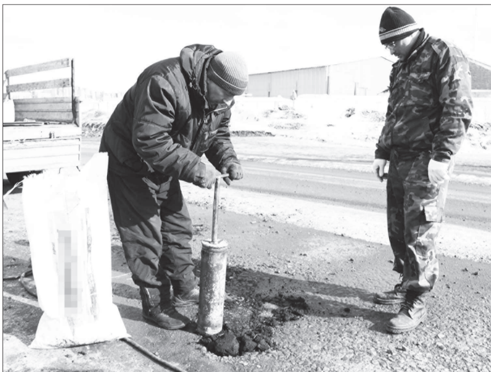
Работники ООО «Город 2000» испытали новый способ ямочного ремонта.
