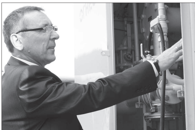
Ф.П.Телпаев у газорегуляторного пункта в Станционном.
