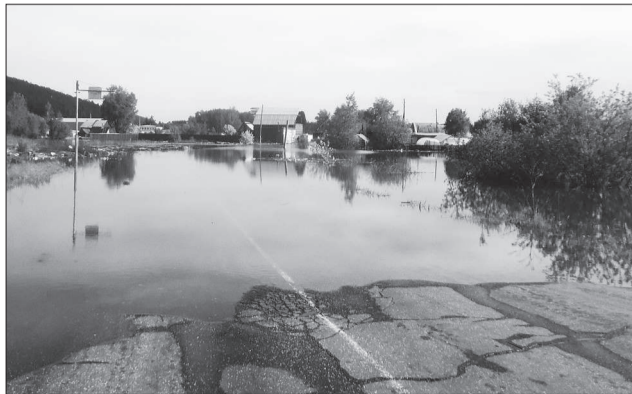
Затопленная дорога в районе ул. Набережной.
