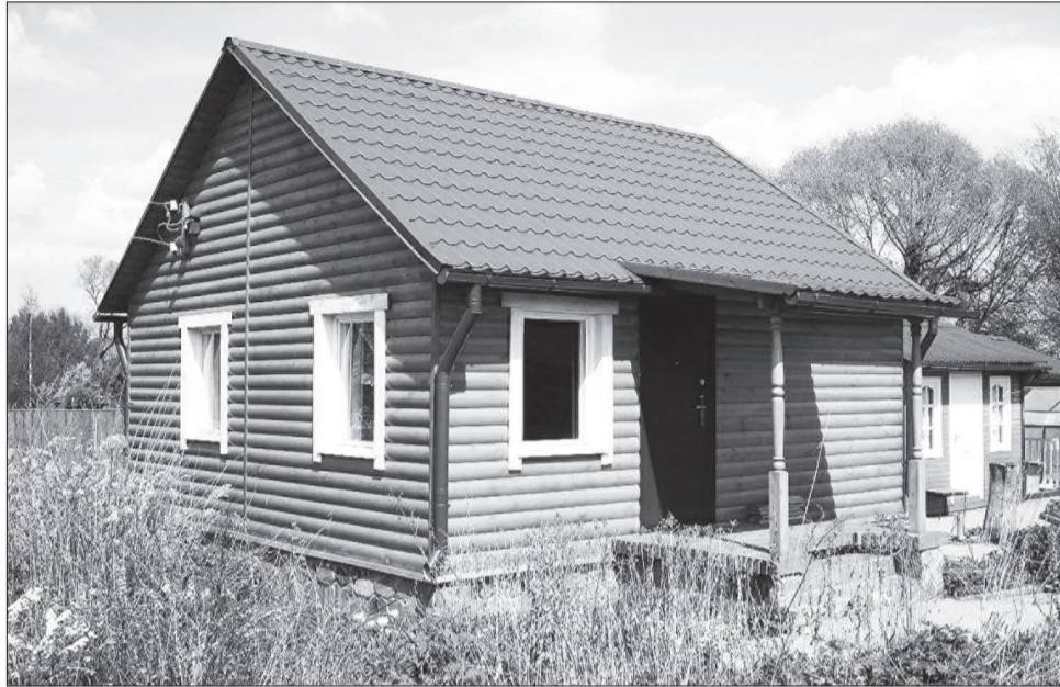
Кровля из металлочерепицы: просто, легко и красиво.
