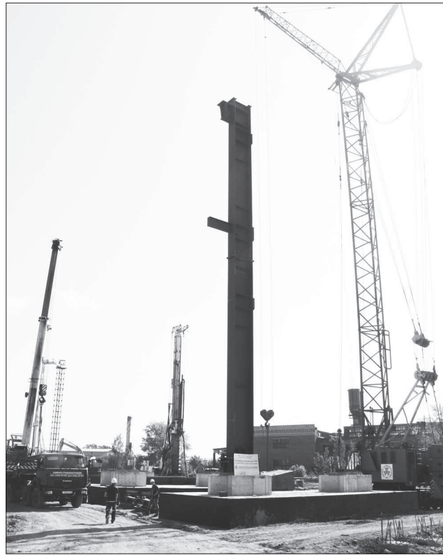
Первая колонна установлена.
