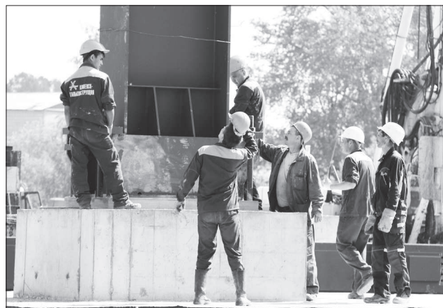
Монтаж колонн ведут работники ОАО «Каменск-Стальконструкция».
