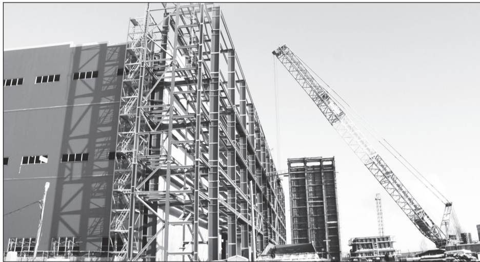
Идёт монтаж каркасов котлов-утилизаторов.
