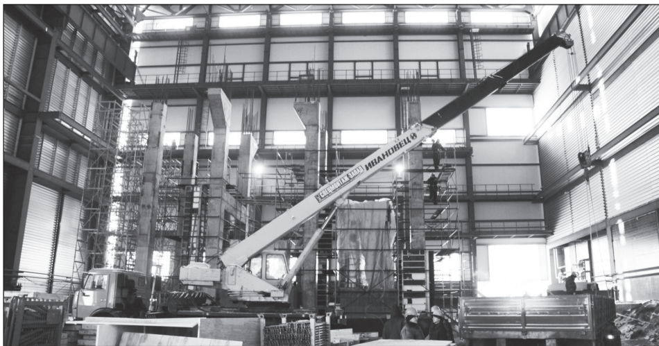
Строители снимают опалубку с фундаментов паровых турбин.
