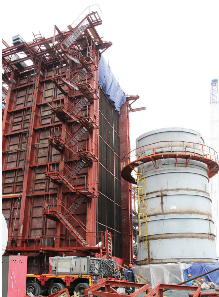
Завершается монтаж котла-утилизатора и основания трубы.
