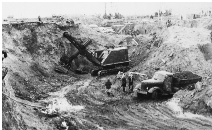
Начало строительства НТ ГРЭС. 1948 год.
