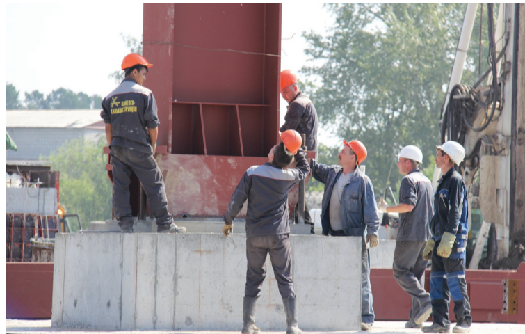
Идет реконструкция НТ ГРЭС. Первую колонну главного корпуса установили 25 июля 2013 г.
