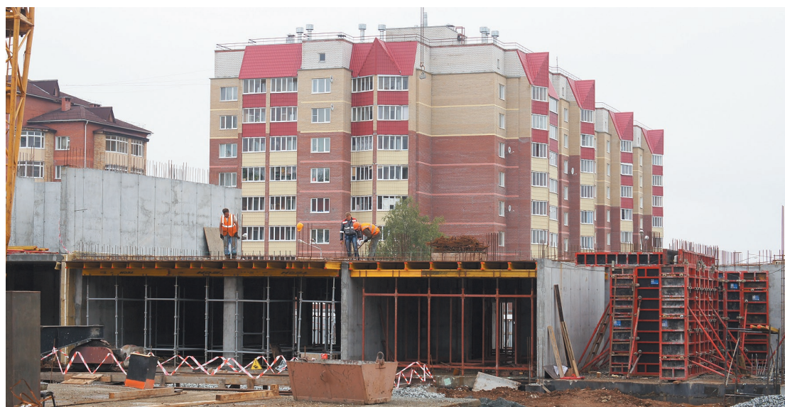
Строющийся объект в Лесном.
