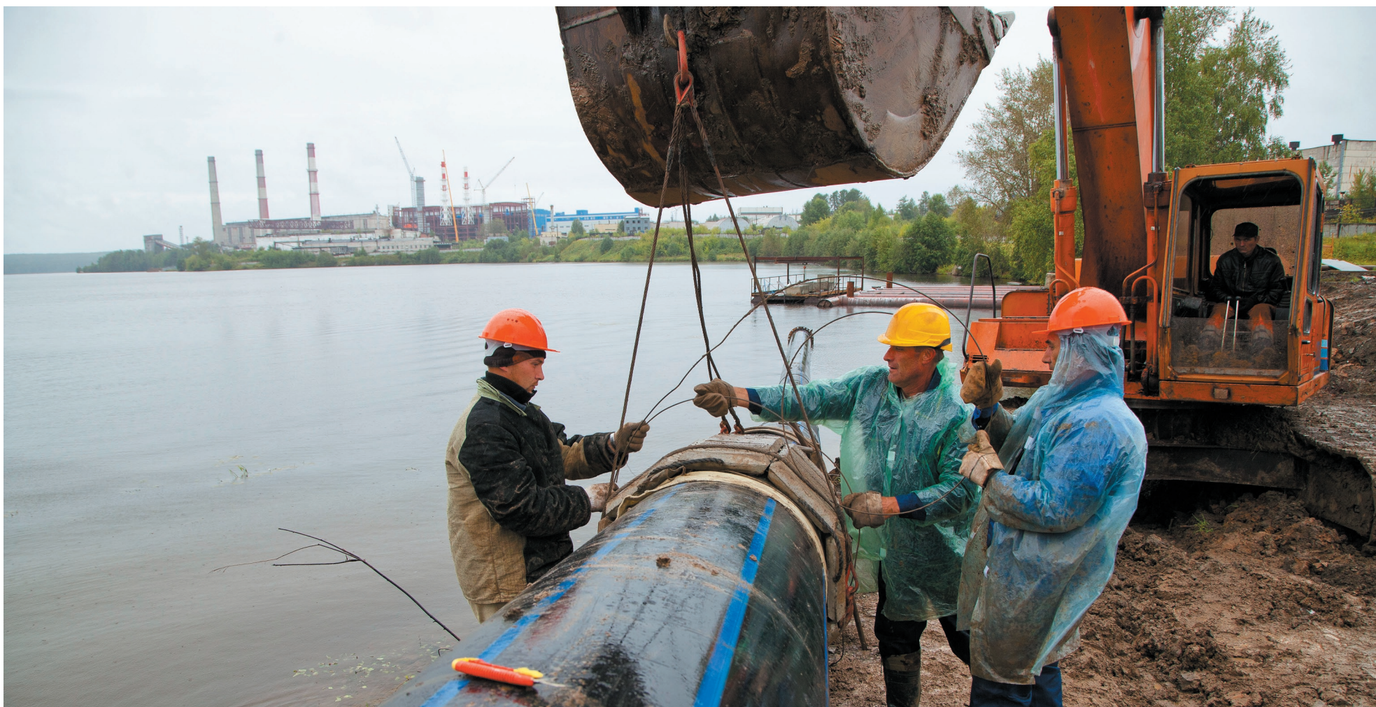
Идет подготовка водовода к погружению на дно водохранилища.
