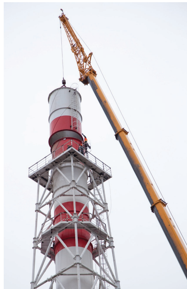
Завершается монтаж дымовой трубы водогрейного котла.
