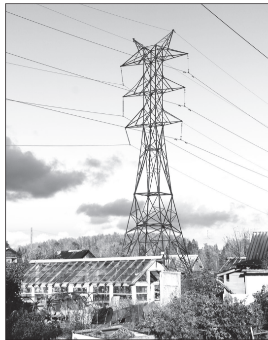
Металлические опоры ЛЭП заменят на бетонные.
