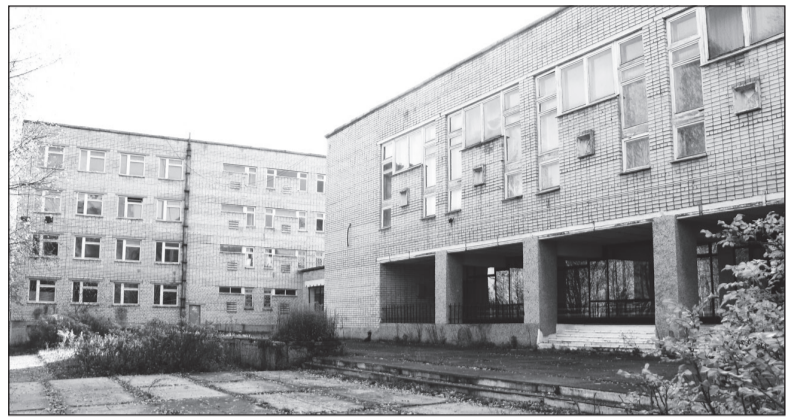
На капремонт и содержание здания бывшего ПЛ-22 из областного бюджета поступит 29 млн руб.
