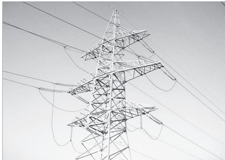
67 млн рублей направит «Свердловэнерго» на реконструкцию линии «НТГРЭС - Уральская 1-2».
