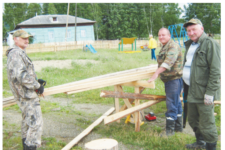
Бригада плотников ЛПУ
