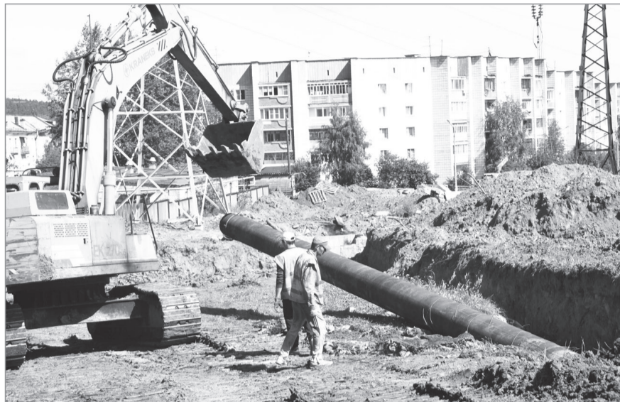
Раскопки на улице Скорынина впечатляют, но благоустройство пройдет только после испытания новой теплотрассы.
