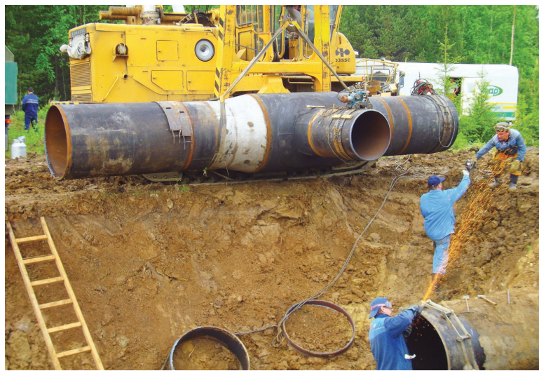
Производится установка «тройника» в газопровод.
