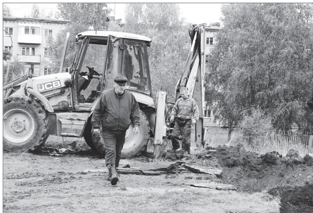
Работы ведет ООО «ЮнивестСтрой».
