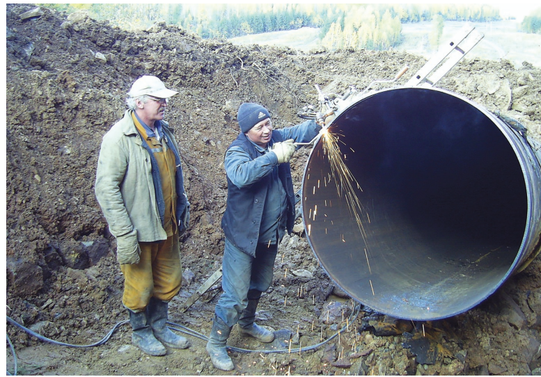
Работники службы ЛЭС подготавливают трубу к сварке.
