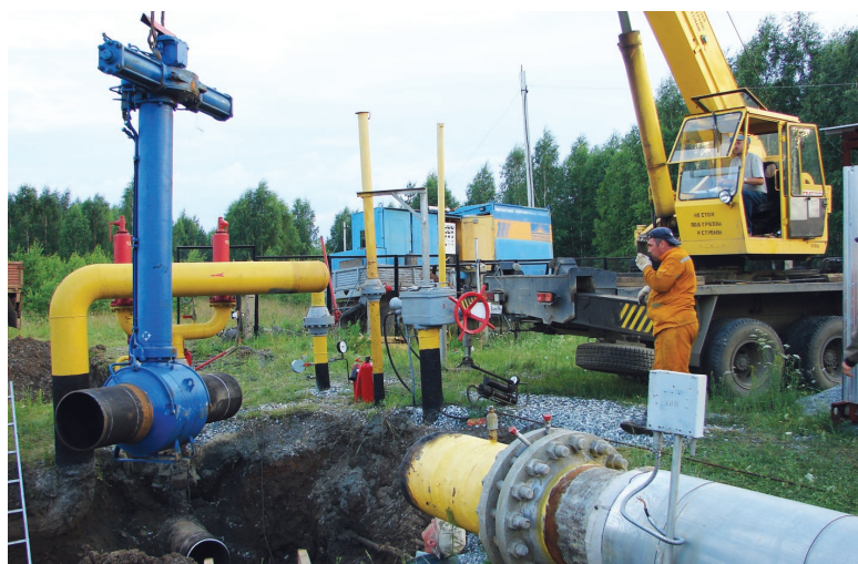
Монтаж запорной арматуры.
