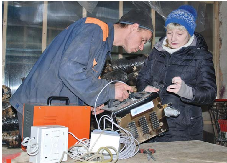
Монтаж нового оборудования для вентиляции
