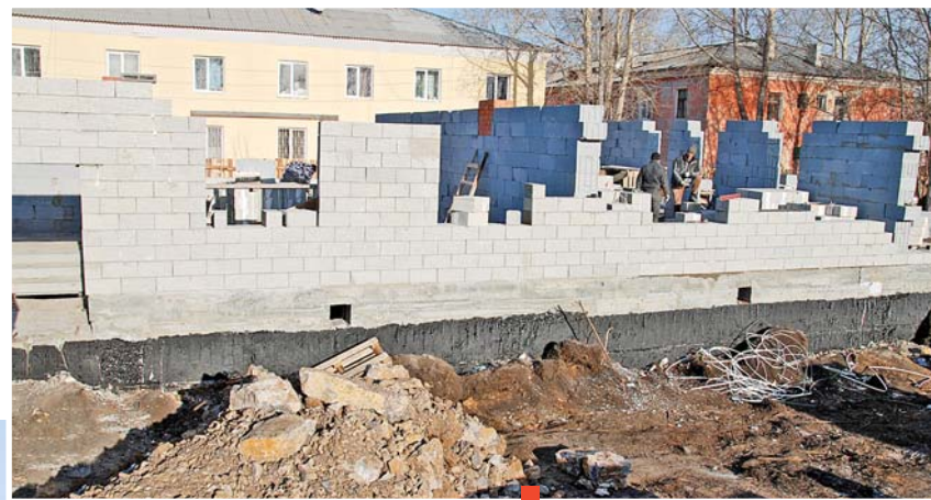
Новостройки в переулках Фрунзе и Буденного
