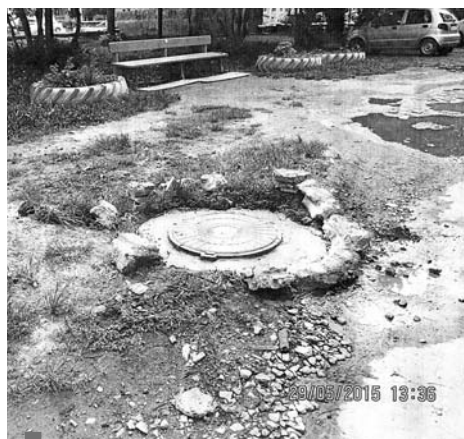
Крышка люка установлена
