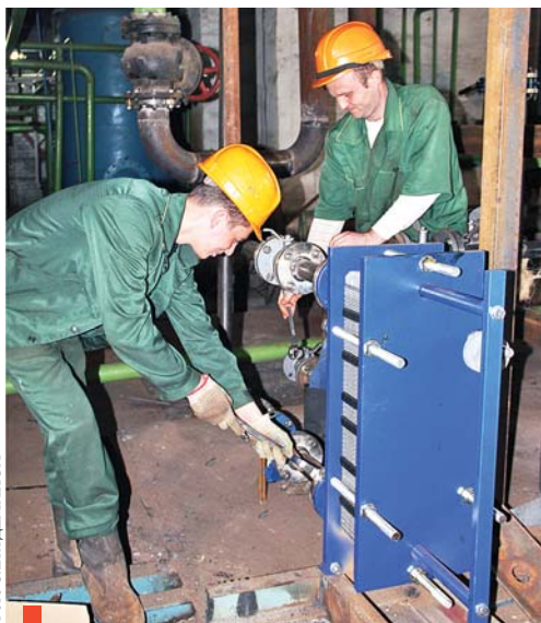
Заканчивается монтаж блока сетевых подогревателей в котельной №11
