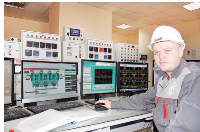
В пультовой цеха «Обжиг». На экране монитора – новый фильтр
