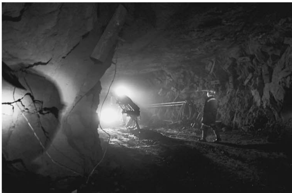
В 2015 году по трём инвестиционным проектам введены в эксплуатацию новые объекты. Это цех холодной прокатки Каменск-Уральского металлургического завода, первый этап строительства шахты «Черемуховская – Глубокая» (на фото) и ангарный комплекс авиационно-технического назначения авиакомпании «Уральские авиалинии».
