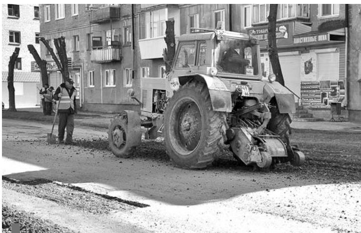
Ямочный ремонт дороги по улице Пушкинской
