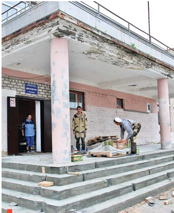
Работы по реконструкции крыльца
