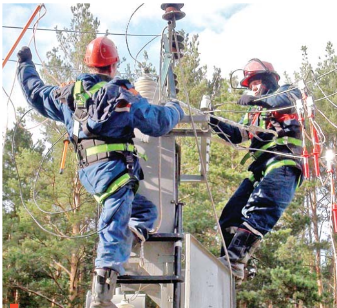
Замена трансформаторной подстанции на линии близ села Филатовского
