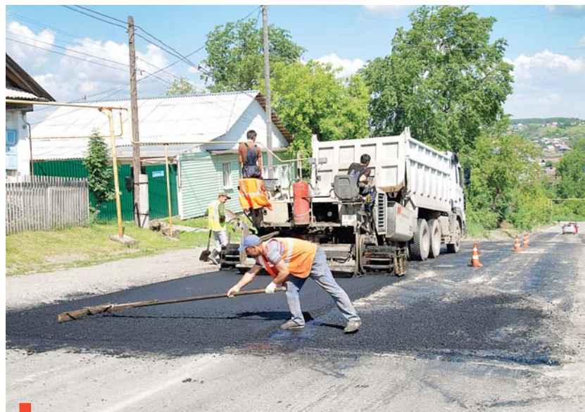
Укладка асфальта на улице Ленина
