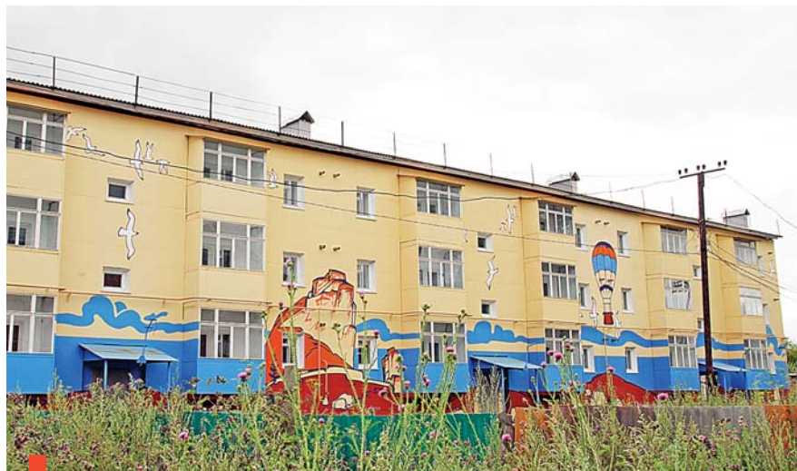
Дом, построенный НП «Знамя», ждет не дожидается новоселов
