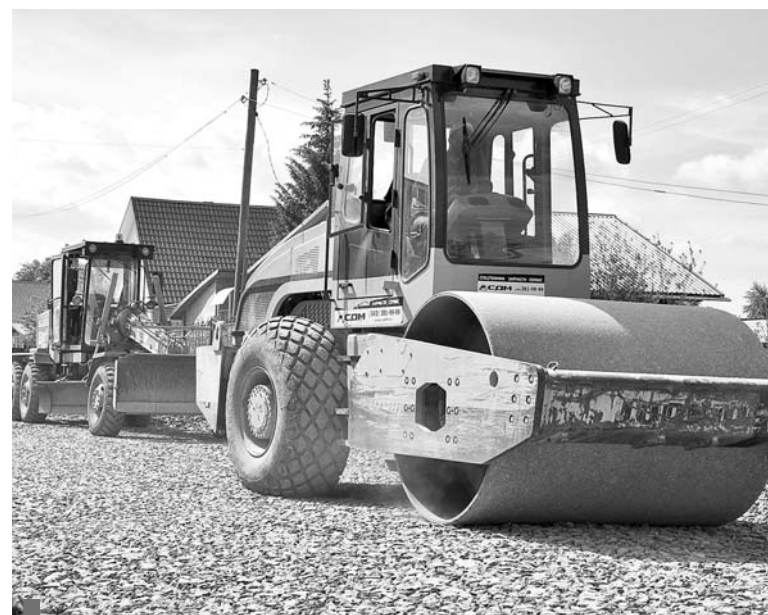
Капитальный ремонт дороги по улице Белинского в Сухом Логу
