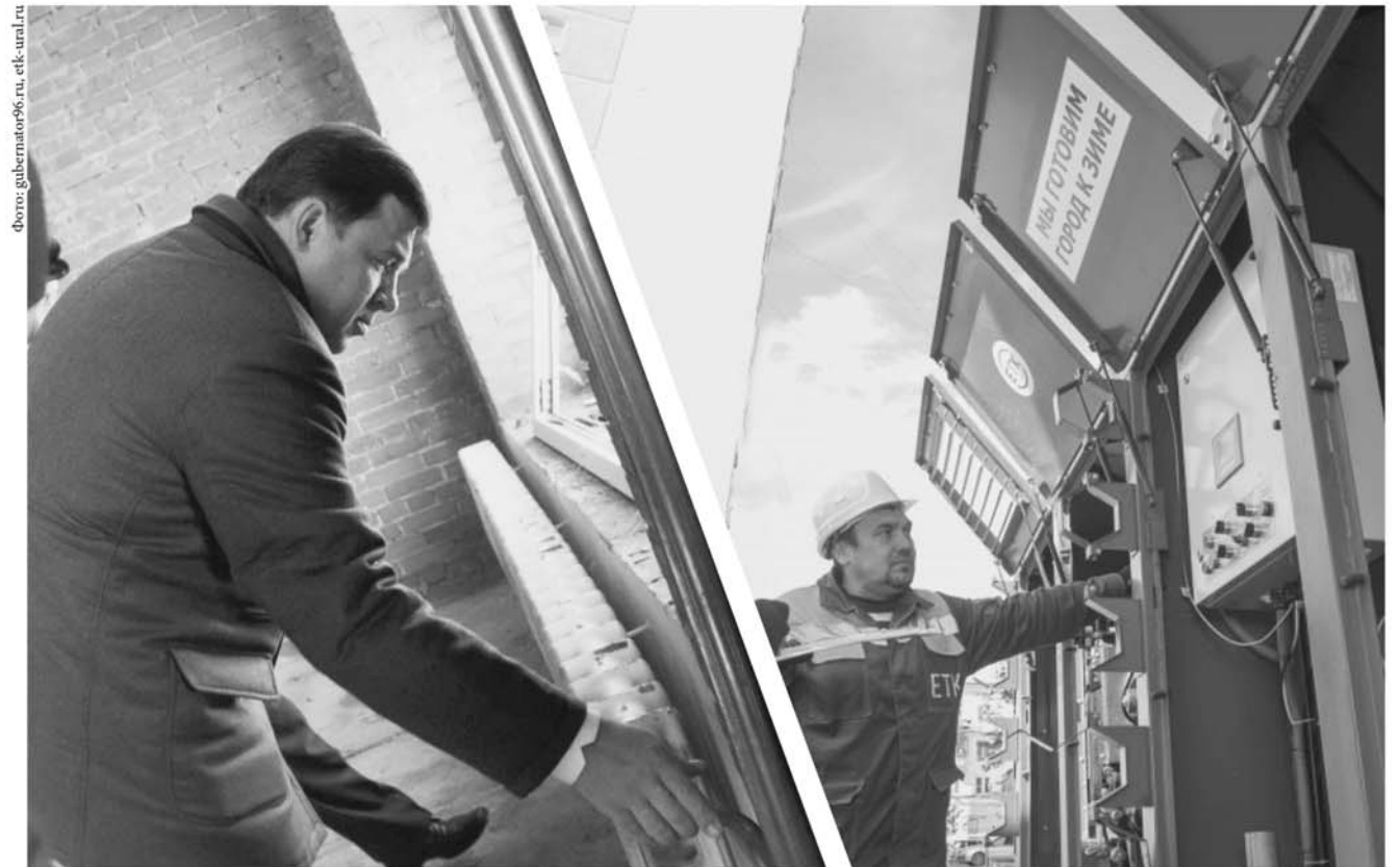
Первоочередная задача – до сентября полностью завершить ремонт внутридомовых систем теплоснабжения.
