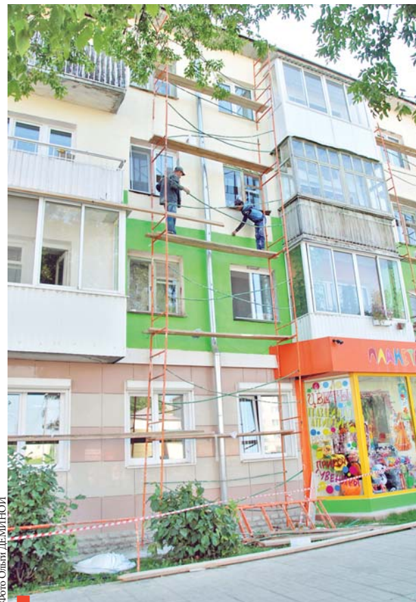
Ремонт фасада дома №5 по ул. Юбилейной
