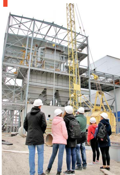
На строящемся объекте
