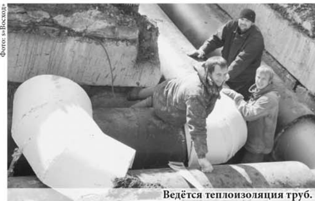
Ведётся теплоизоляция труб.
