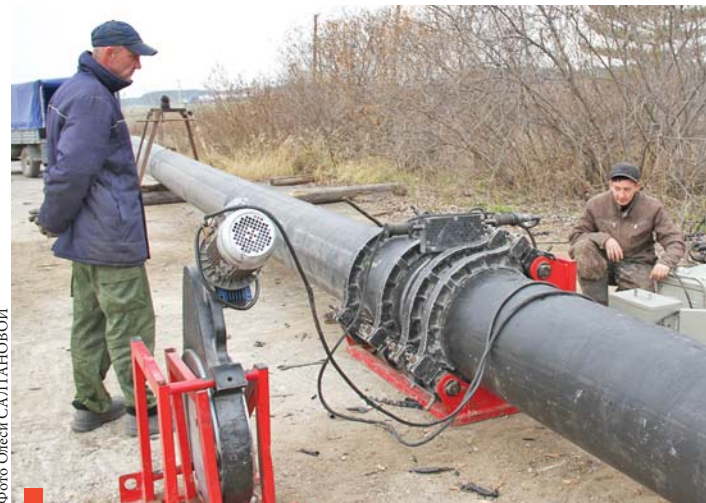
Наложение сварного шва на участке водовода Курьи – станция обезжелезивания
