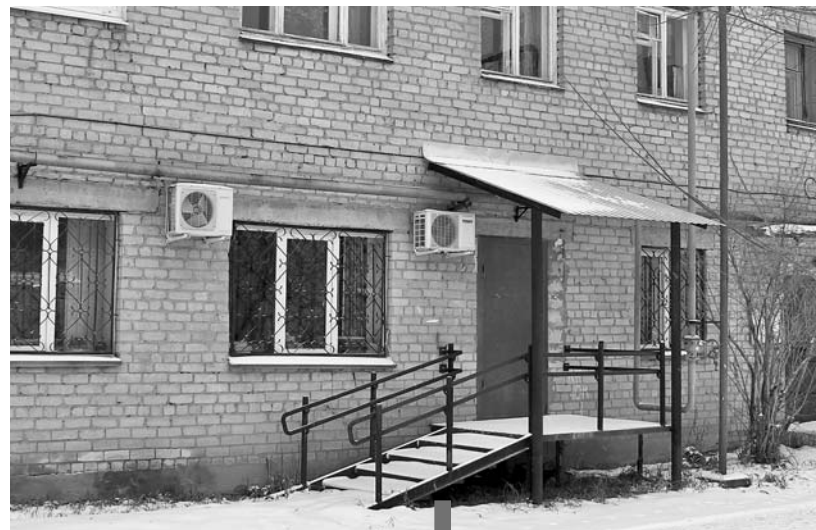
Металлический козырек над запасным выходом
