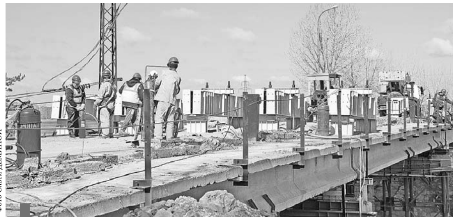
В данный момент идет капремонт моста ОАО «Сухоложскцемент»
