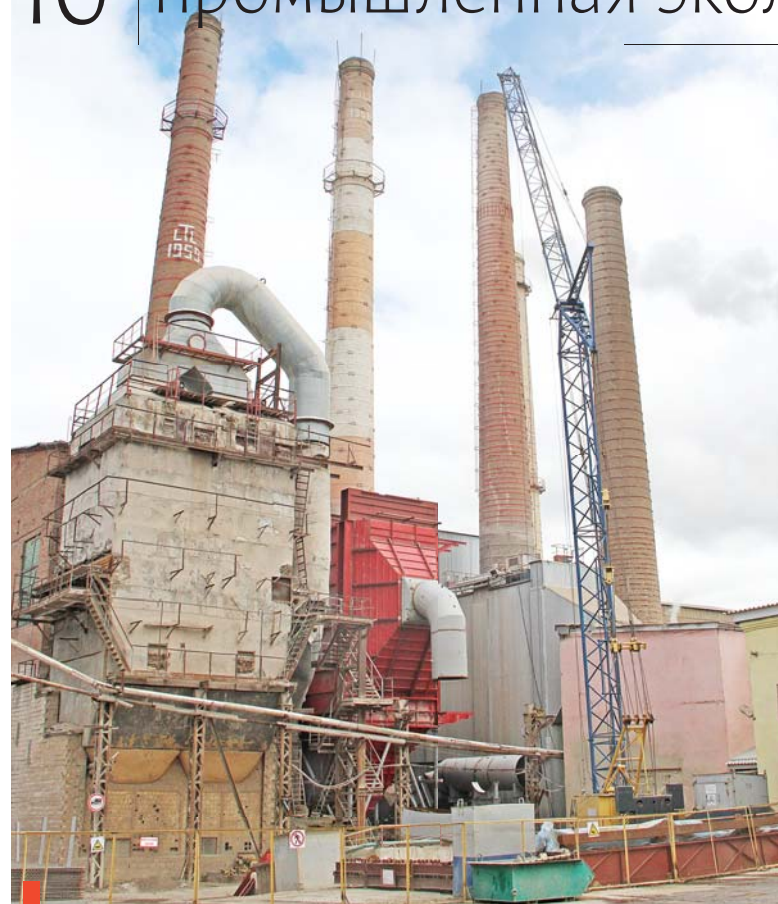
Замена электрофильтров на обжиговых печах
