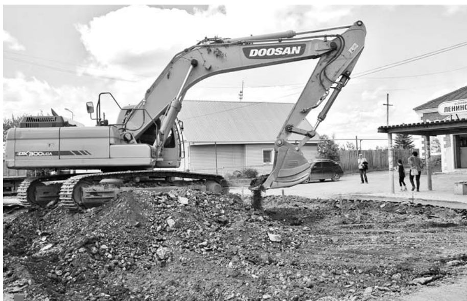
По улице Ленина снимают старое покрытие дороги
