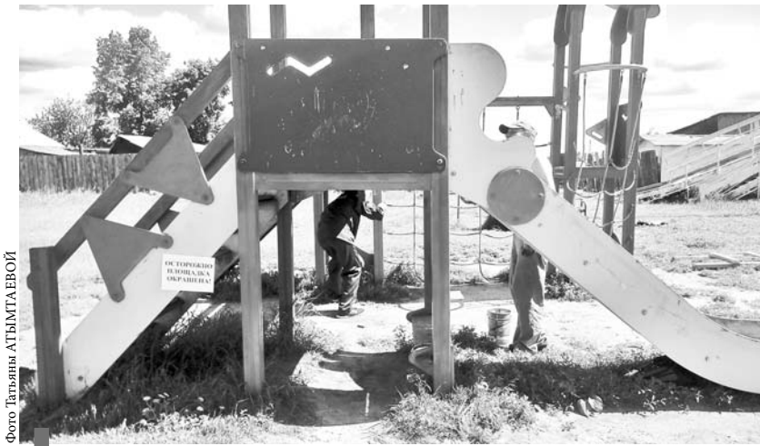
Работники «Горкомхоза» ремонтируют детскую площадку
