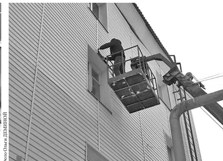
Ремонтные работы на фасаде многоквартирного дома №8 по ул. Гагарина
